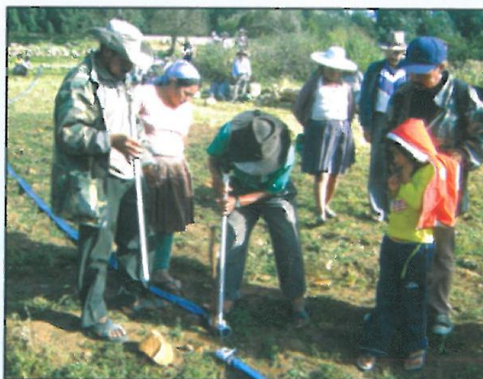
Colocado del porta-aspersor en forma vertical
